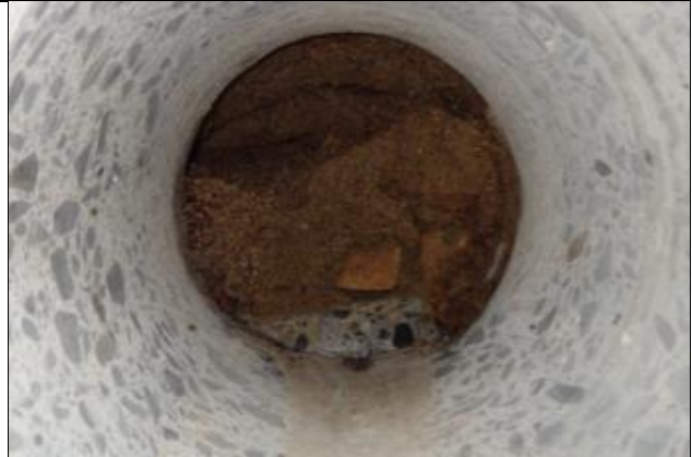
Kuva 2. Näkymä sokkelin porausreiästä täyttösorakerokseen.
