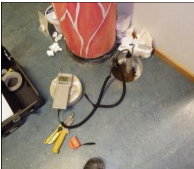
Kuva 9. Alapohjan rakennetutkimuskohta käytävässä 161. Alapohjalaatan paksuus tutkimuskohdassa on 60 mm.
