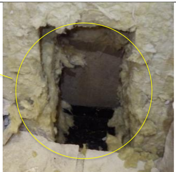
Kuva 6. Eristetilän pohjalla on bitumisively.
