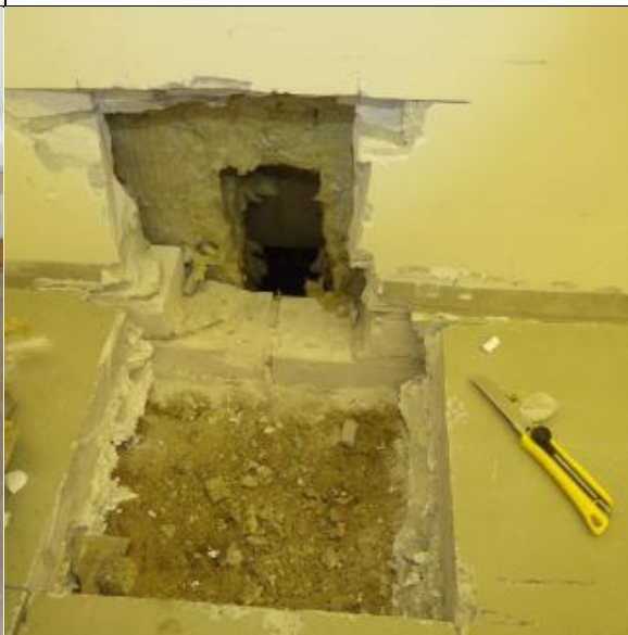
Kuva 12. Alapohjan rakennetutkimuskohta varastossa 108.
