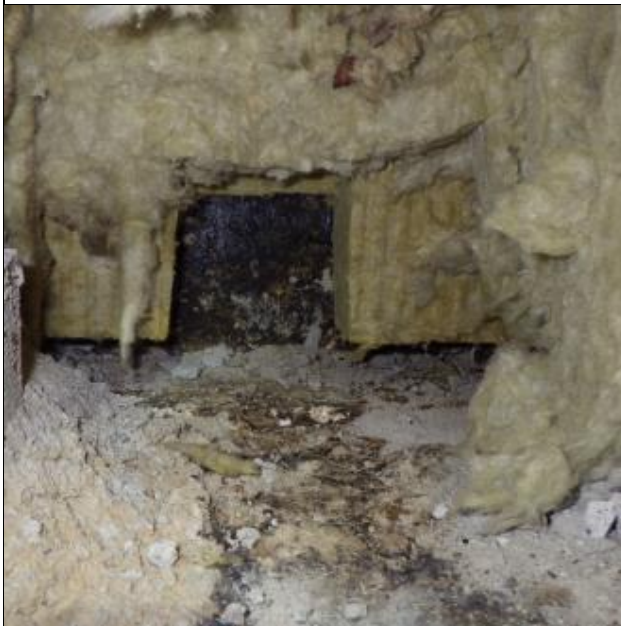
Kuva 3. Huoneen 17 rakenneavauskohdassa näkyvissä valesokkelin sisäpuolinen bitumieristettä.
