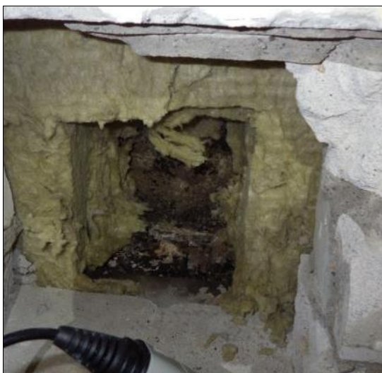
Kuva 8. Ulkoseinän rakennetutkimuskohta huoneessa 7.
