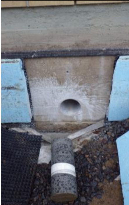
Kuva 1. Sokkelin rakennetutkimuskohta.
