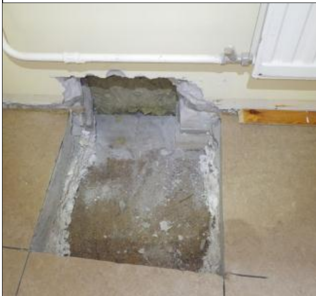
Kuva 11. Alapohjan ja ulkoseinän rakennetutkimuskohta huoneessa 7.
