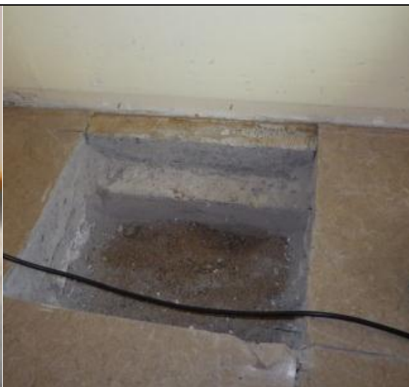
Kuva 10. Alapohjan rakennetutkimuskohta huoneessa 7. Kuvassa näkyy betoniväliseinän anturaa.
